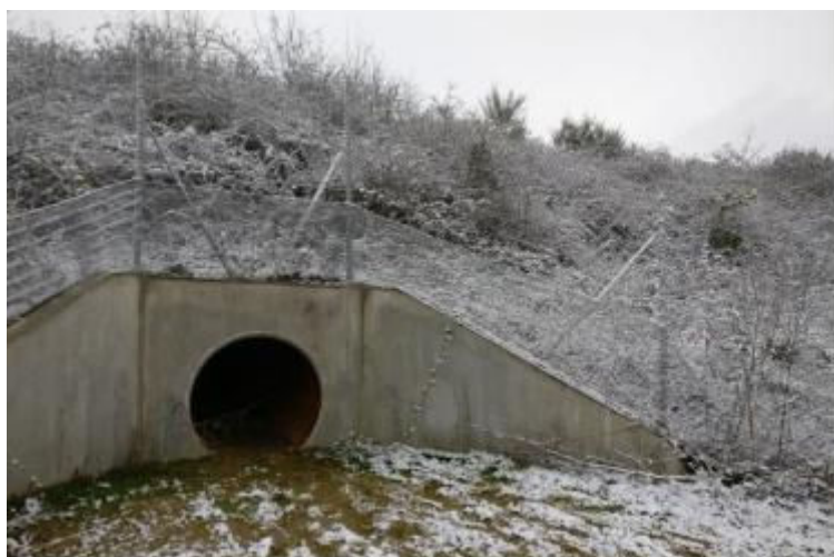
Figure 154 : Ecoduc de Castelnau d'Estrétefonds - NEO
