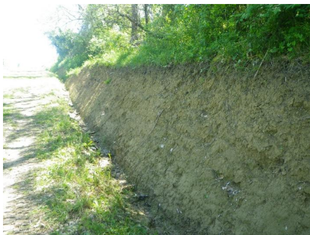
Figure 167 : Exemple de gestion de talus défavorable aux reptiles
